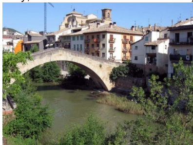
Puente de la Cárcel over de rio Ega
