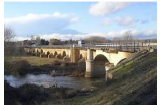
Puente de Villarente
